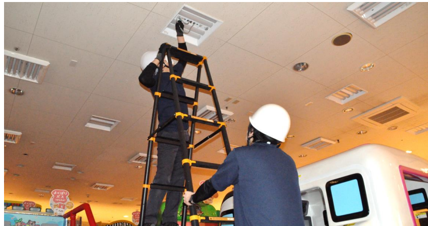
天井照明の蛍光灯をLED化
