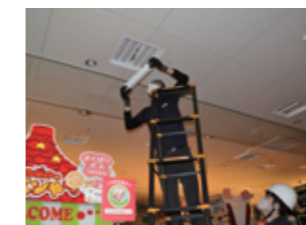
天井照明のLED化工事
