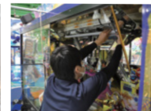
工事はすべて当社メンテスタッフが実施
